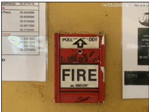
ภาพที่ 24 สวิตช์แจ้งสัญญาณอัคคีภัยด้วยมือ
